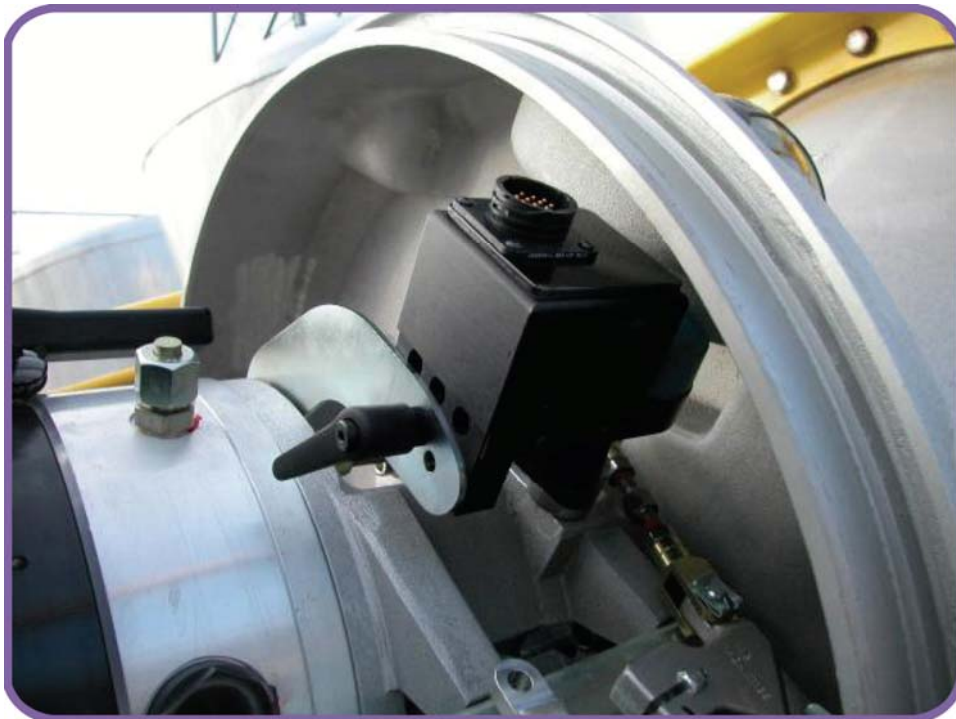
Figura 28. Transductor Rotacional en un ABB HMB Mech
