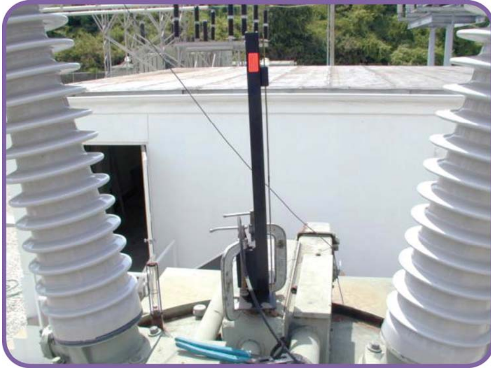
Figura 26. Transductor Lineal en un OCB
